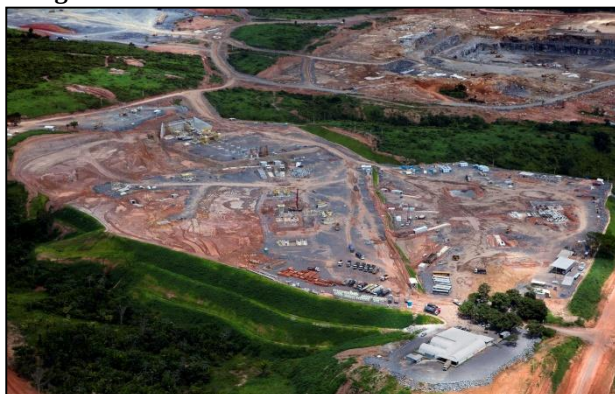
Fotografia 15 - Abertura de canteiros 1.
