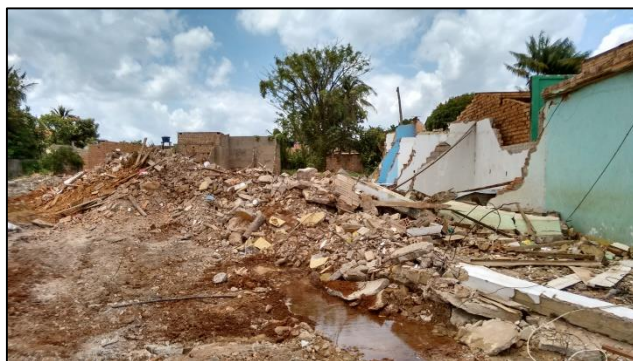
Fotografia 25 - Demolições em Altamira 2
