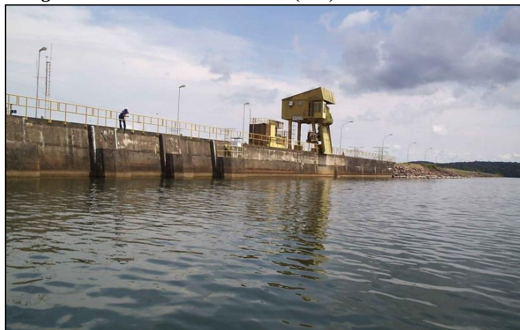
Fotografia 5 - Hidrelétrica de Balbina (AM).
