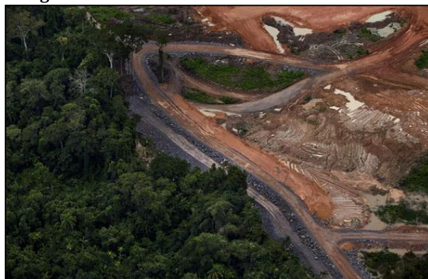
Fotografia 16 - Abertura de canteiros 2.
