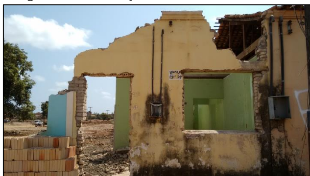
Fotografia 27 - Demolições em Altamira 4
