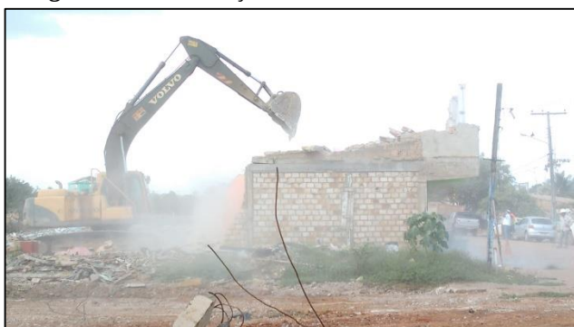
Fotografia 26 - Demolições em Altamira 3
